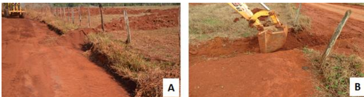
Figura 2. Construção das bacias de retenção: mudança do abaulamento da pista (A) e execução do canal (B).
