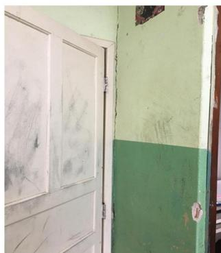
**Figura 9:** Fissura vertical em junção de paredes.
