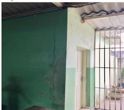
**Figura 8:** Fissura vertical na alvenaria acompanhando o pilar.
