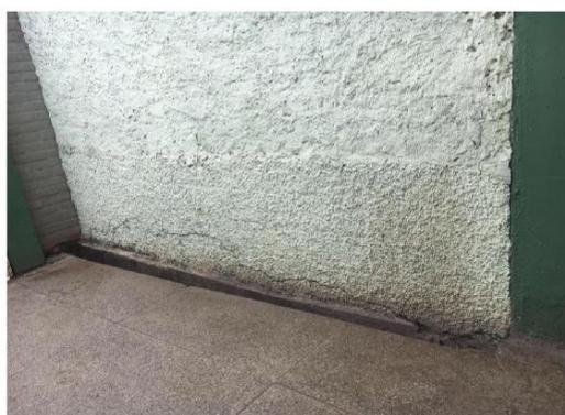
**Figura 15:** Fissura horizontal na alvenaria do muro.
