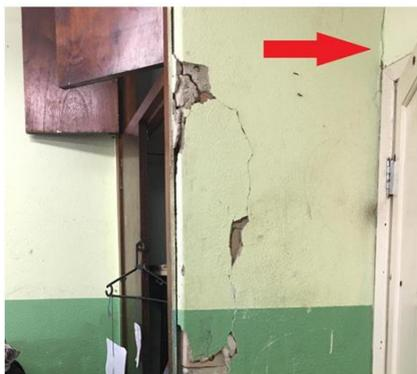
**Figura 10:** Fissura vertical em junção de paredes.
