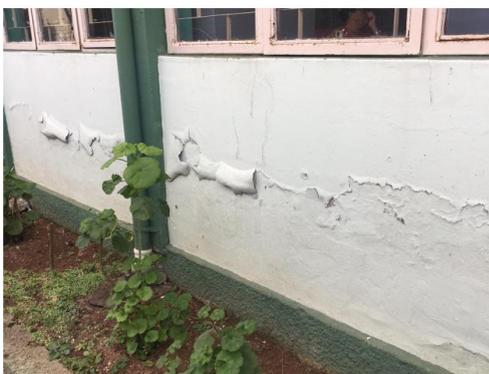
**Figura 14:** Destacamento da pintura na fachada da escola.
