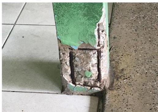
**Figura 16:** Armadura aparente no pilar.
