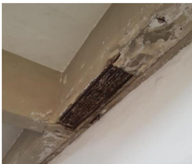
Figura 4: Desagregação do Concreto.
