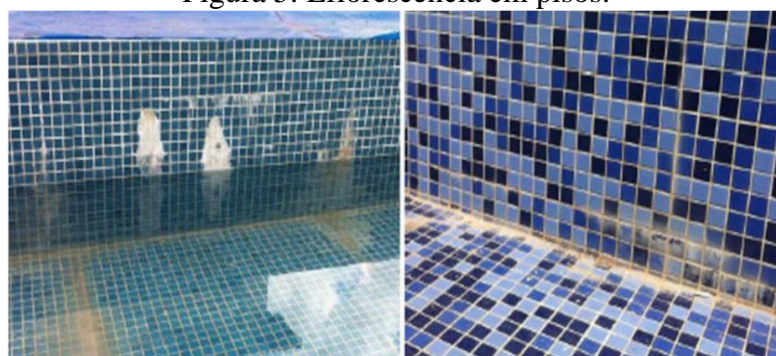
Figura 5: Eflorescência em pisos.
