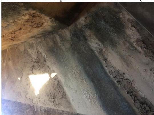
Figura 12: Mofo da parte interior da obra (escada).
