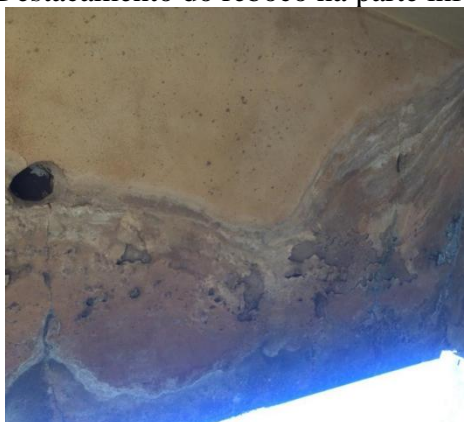
Figura 11: Destacamento do reboco na parte inferior da laje.
