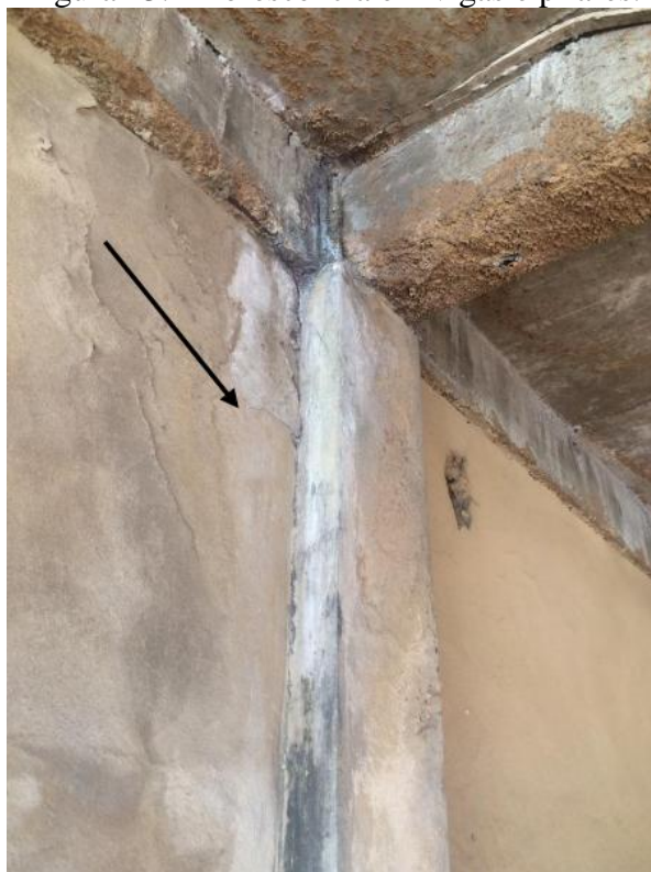
Figura 13: Eflorescência em vigas e pilares.
