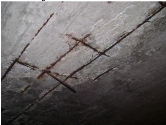
Figura 3: Corrosão da armadura.
