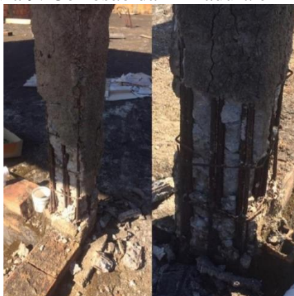
Figura 9: Corrosão da Armadura em Pilar.
