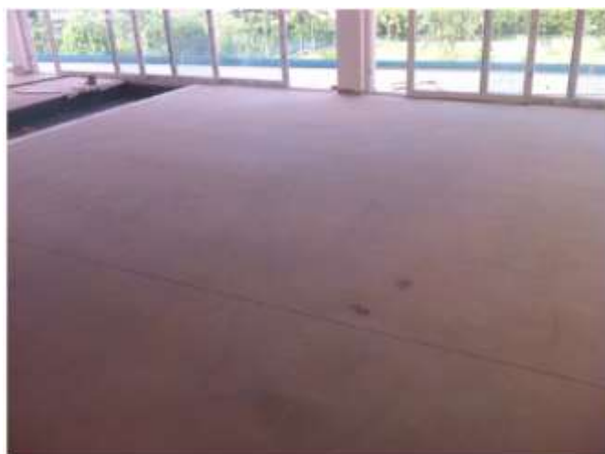
Figura 3.4 – Resultado do Concreto Branco Polido.
