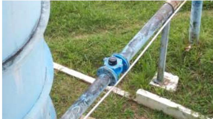
**Figura 2** – Medidor de Vazão localizado na saída dos Filtros (ETA).
