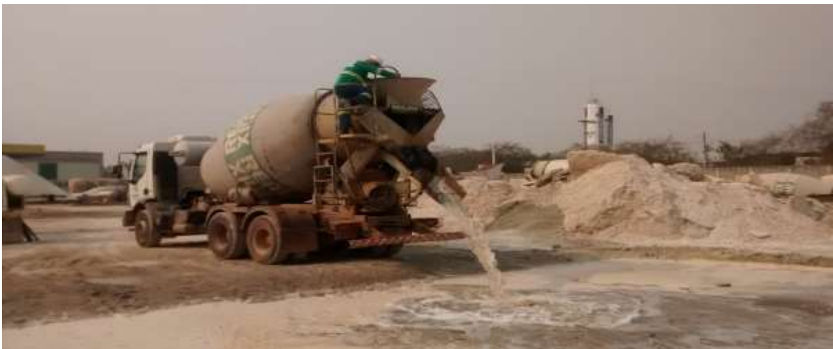
Figura 3: Processo de lavagens do balão do caminhão Betoneira.
