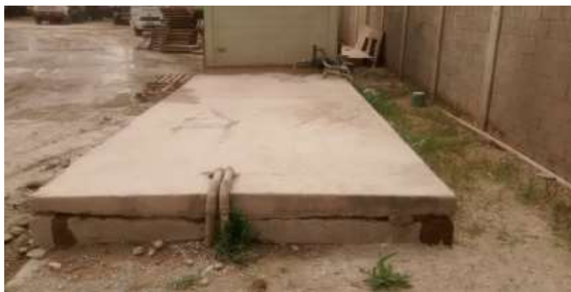
Figura 5: caixa d' água subterrânea para armazenamento e reuso de água.
