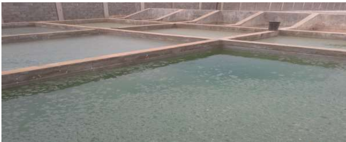
Figura 4: Decantador da Empresa Realmix Concreto para recebimento da efluente de betoneira.
