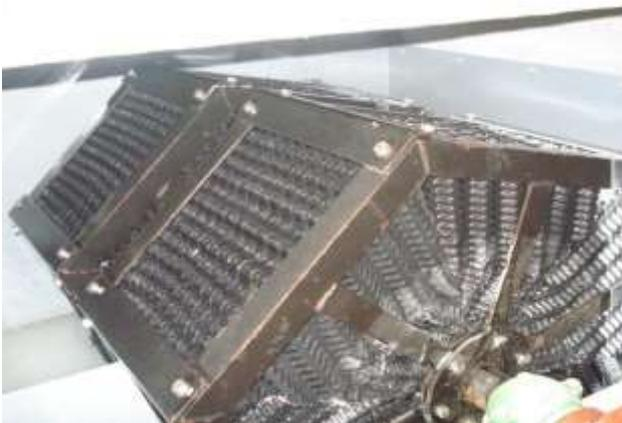
Figura 2– Rotor horizontal do tanque de tratamento biológico
