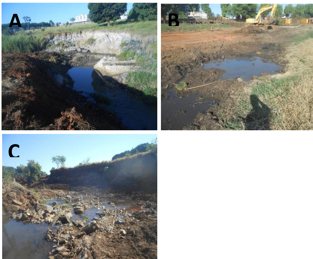
Figura 06: Trecho T4 - Letras (A-D) correspondem a problemas encontrados no trecho 5. A) Perda das matas ciliares, Geração e Transmissão de energia B) terrenos alagadiços e sujeitos a inundações C) Processo erosivos.
