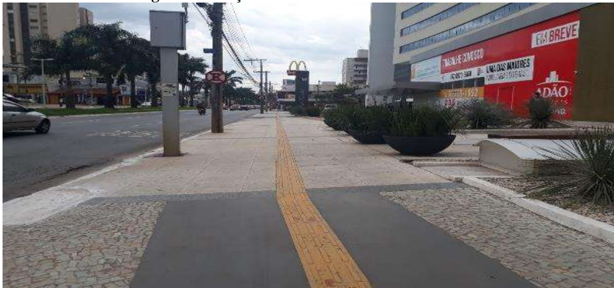
Figura 5 – Calçadas no entorno do edifício analisado
