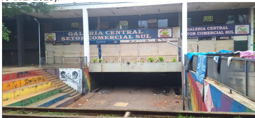
Figura 6. Foto a nível do térreo do Buraco do rato no Setor Comercial Sul em 2025. Fonte: Autora, 13 dez. 2025).
