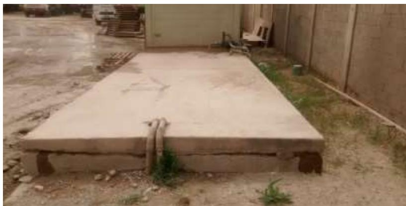
**Figura 5:** caixa d' água subterrânea para armazenamento e reuso de água.
