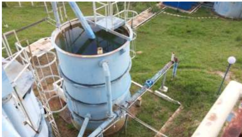
Figura 3 – Locação a montante da descarga dos filtros.
