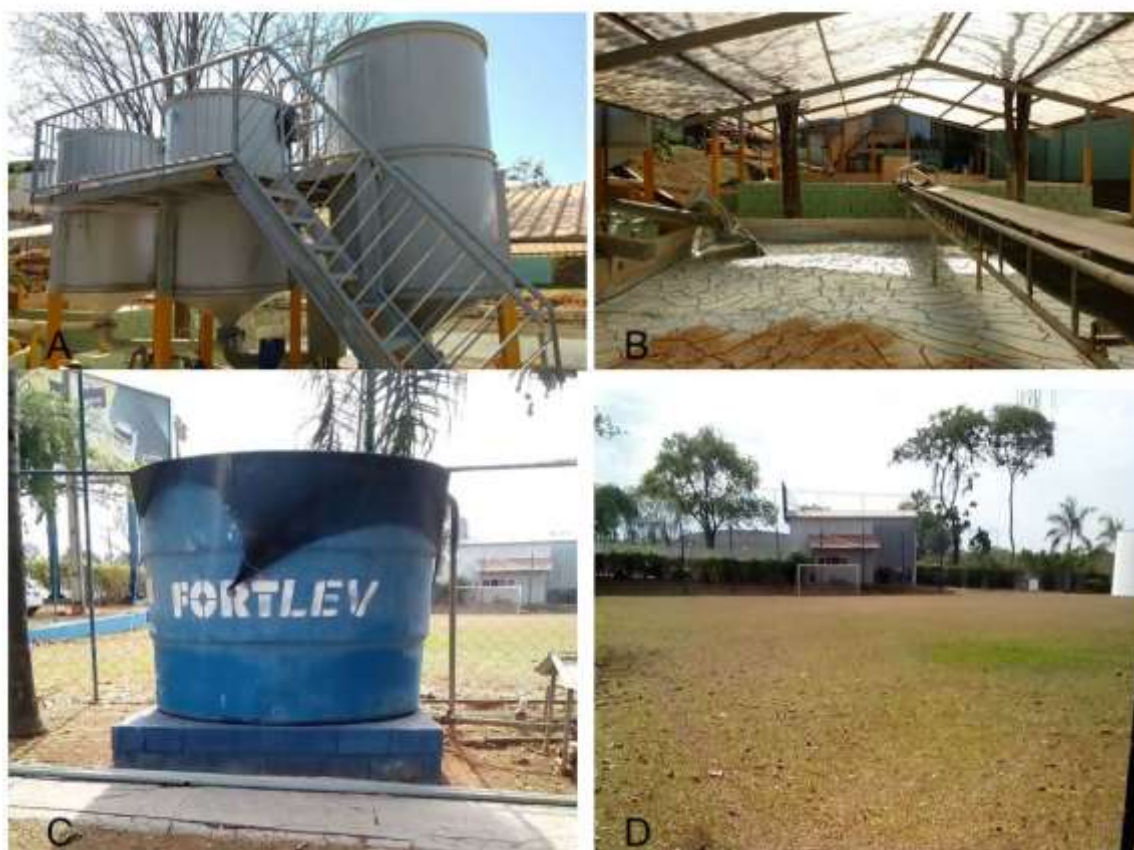
Figura 3. Seguimento do tratamento do efluente líquido. A decantadores tipo batelada; B leito de secagem de lodo; C. armazenamento de água para reúso; D campo onde ocorre o processo de fertirrigação.
