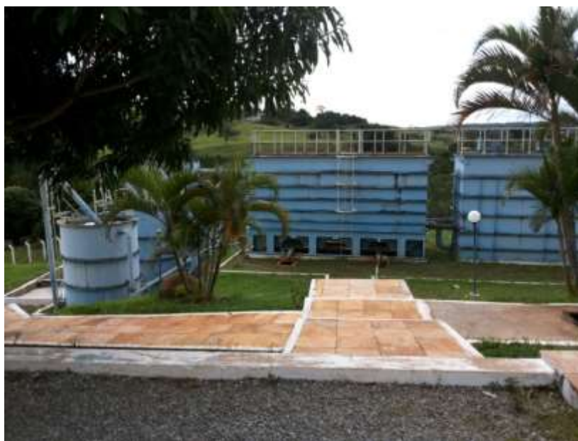
Figura 1 – Estação de Tratamento de Água de Corumbá/GO.
