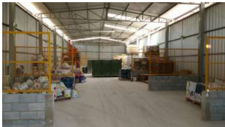
Figura 11. Central de Triagem de Resíduos Sólidos.
