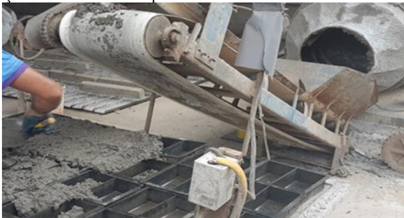
Figura 1 – Lançamento do concreto e preenchimento das formas.
