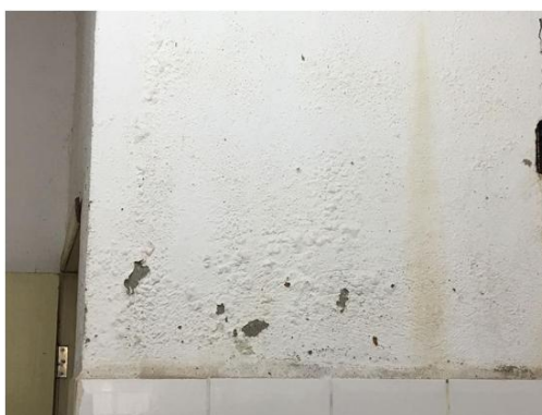
Figura 12: Bolor e destacamento da pintura no banheiro feminino.
