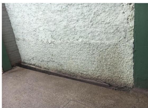
Figura 15: Fissura horizontal na alvenaria do muro.
