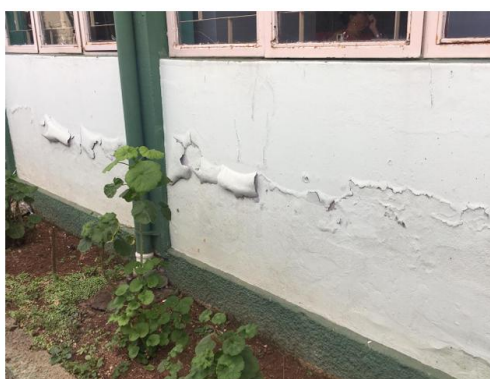
Figura 14: Destacamento da pintura na fachada da escola.
