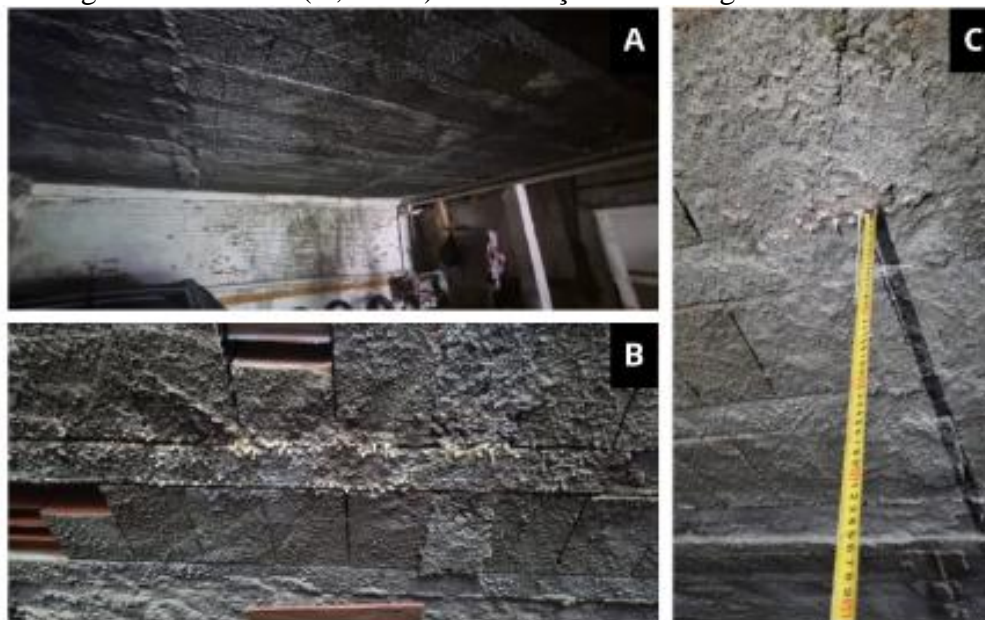
Figura 9 – Detalhe (A, B e C) Deformação e flambagem da estrutura.
