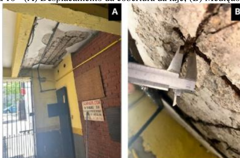
Figura 10 - (A) Deslocamento da cobertura da laje; (B) Medição da armadura.
