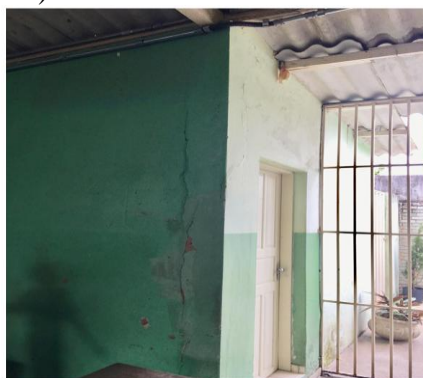
Figura 8: Fissura vertical na alvenaria acompanhando o pilar.
