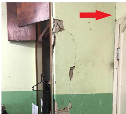
Figura 10: Fissura vertical em junção de paredes.
