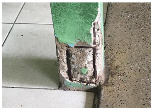
Figura 16: Armadura aparente no pilar.
