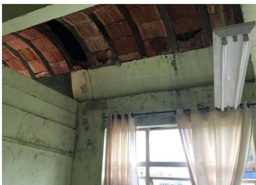
Figura 11: Bolor na parede da sala de aula.
