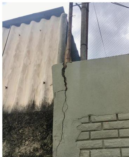
Figura 17: Brechas no muro da frente.
