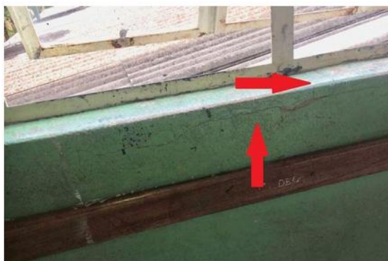
Figura 13: Fissuras nos peitoris das janelas.
